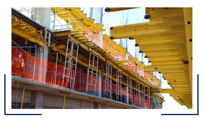
**Extrabeam H20** es la viga de encofrado más sólida y más ligera hecha de madera de abeto y picea. Nuestras vigas de encofrado son fabricadas en varias longitudes estándares.
